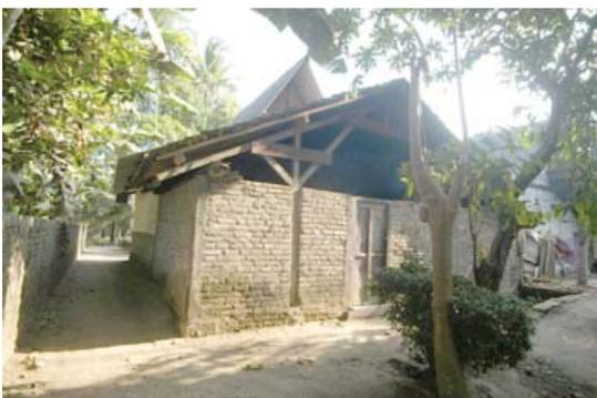
Foto 8. Penambahan Rangka Struktur Kayu pada Bagian Belakang Rumah no. 10.
