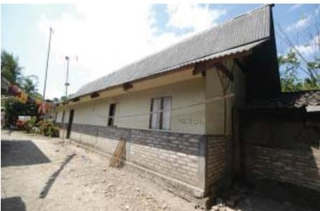
Foto 7. Rumah no. 49 dan 50 dengan konfigurasi modul struktur memanjang
